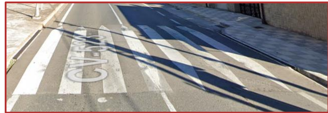
Ilustración 102 Paso sobreelevado para el calmado de tráfico
