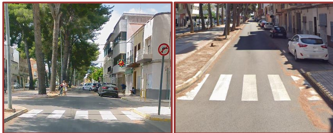
Ilustración 28 Falta de rampas o adecuación a PMR c/ Gran Vía
