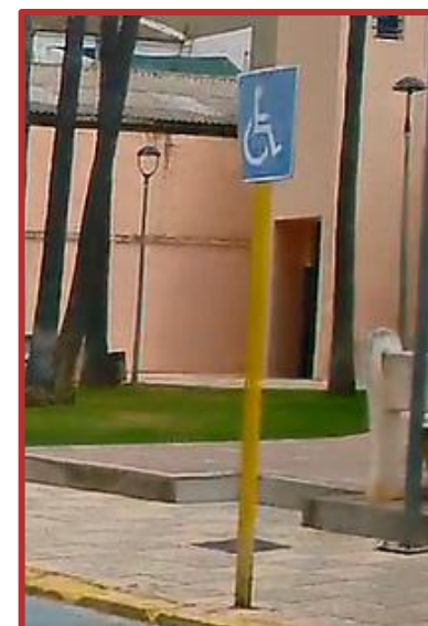
Ilustración 101 Ejemplo de señal descolorida en c/ del Pare Efrén
