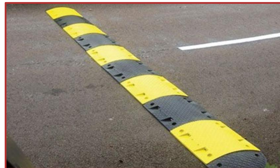
Ilustración 103 Bandas reductoras de velocidad para el calmado del tráfico
