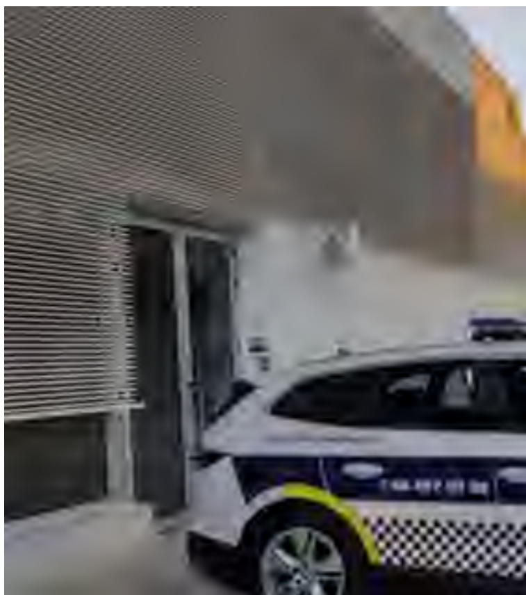
Façana edifici policia local de Guadassuar
