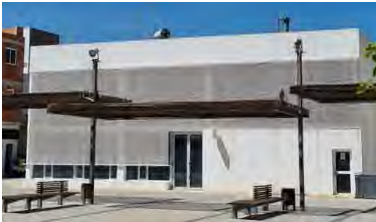
Façana edifici policia local de Guadassuar
