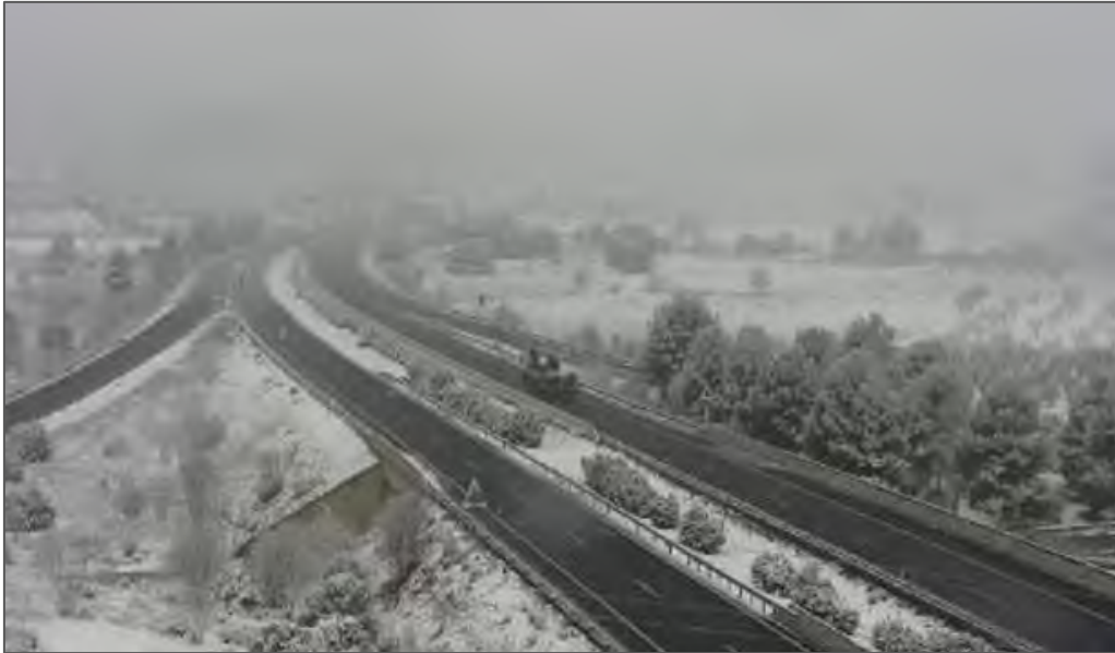
Figura 31. Efectos en carreteras de la Ribera como consecuencia del temporal de nieve provocado por Filomena. Fuente: Las Provincias (2021).
